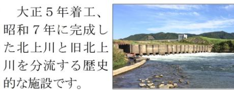
大正5年着工、昭和7年に完成した北上川と旧北上川を分流する歴史的な施設です。大きさは、延長37m、水通し部は各門幅0.94mで18門あり、高さ1.35mです。構造は、自然流下により水流を一定量
