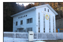
豊里耕土を潤す 境沢揚水機場
